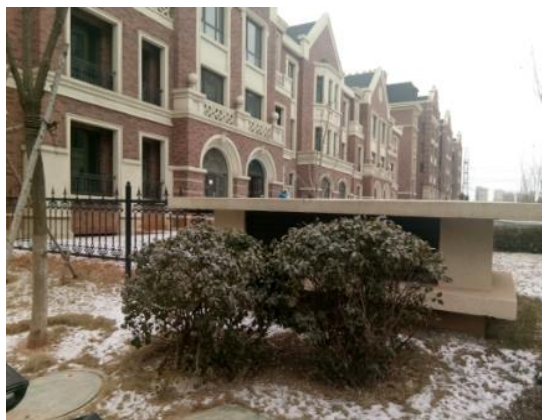
图 4-1 绿化带排气口
