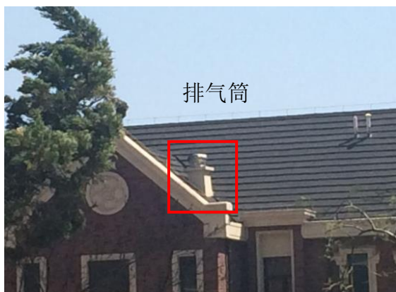
图 4-5 住宅屋顶排气筒位置图
